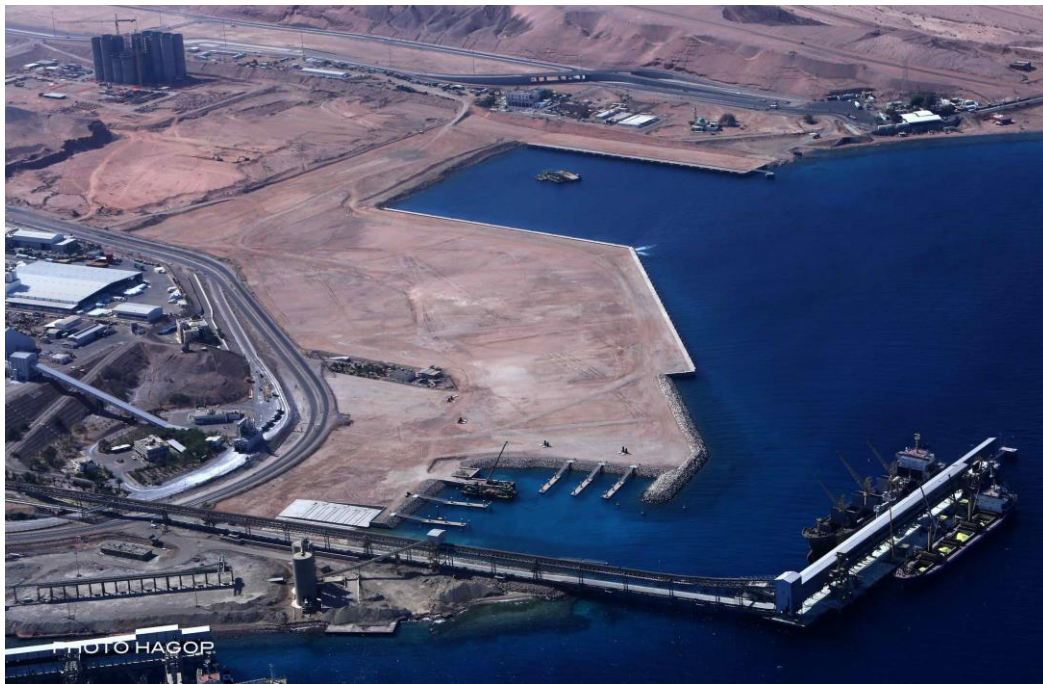
Aqaba New Port während der Bauphase vor Errichtung von Gebäuden, Lagerflächen und Abschluss des Hafenbeckens und Kaianlagen. (Foto: Aqaba Development Corporation)
