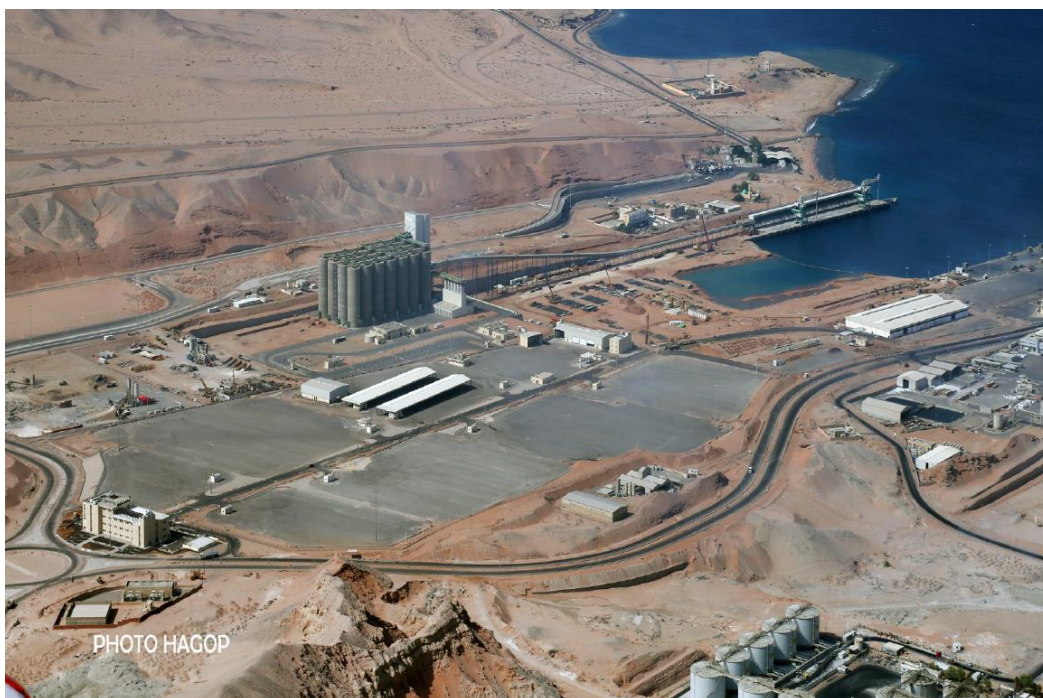
Aqaba New Port während der Bauphase im September 2017 nach Errichtung der ersten Verwaltungsgebäude, Lagerflächen, Verkehrsinfrastruktur. (Foto: Aqaba Development Corporation)
